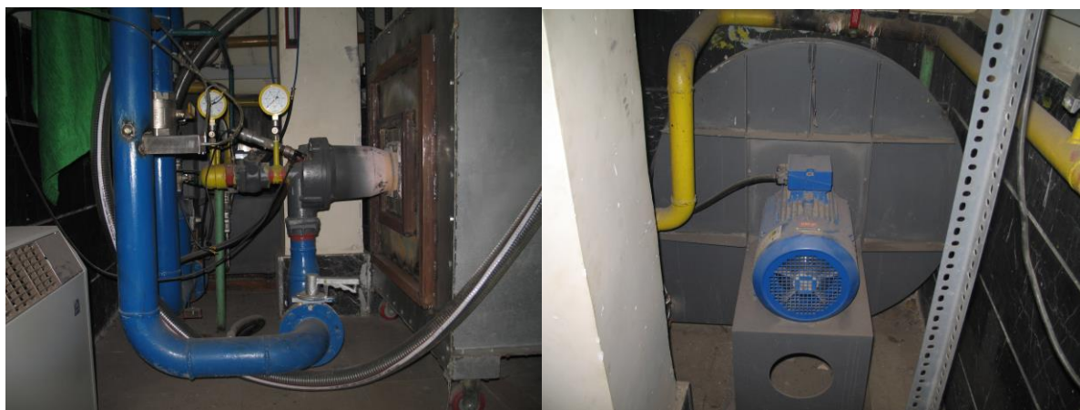
شکل ۲ - سامانه‌ی تأمین هوای ورودی
